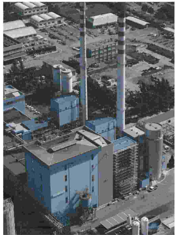
La Centrale di Lamarmora è pronta alla decarbonizzazione già entro la fine dell'anno
